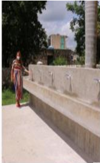
Instalación de lavabos y dispensadores de gel
